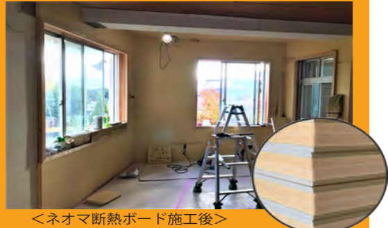
<ネオマ断熱ボード施工後>
