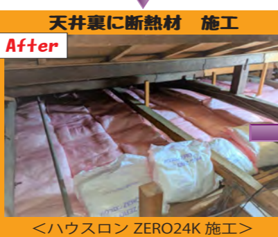
<ハウスロン ZERO24K 施工>
